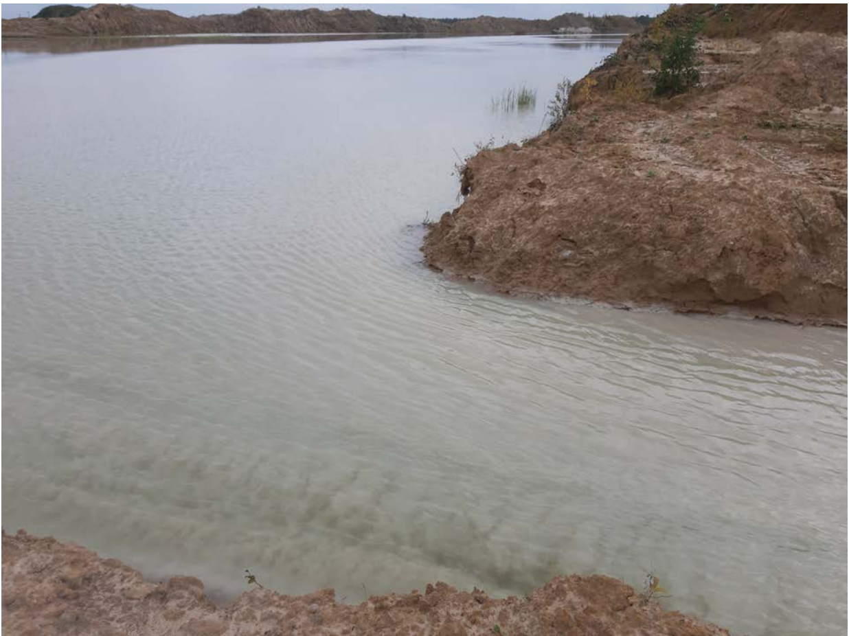
Малюнок 6 Потік освітленої води на виході ємності №21, що змішується з осадом. 28.09.2021
